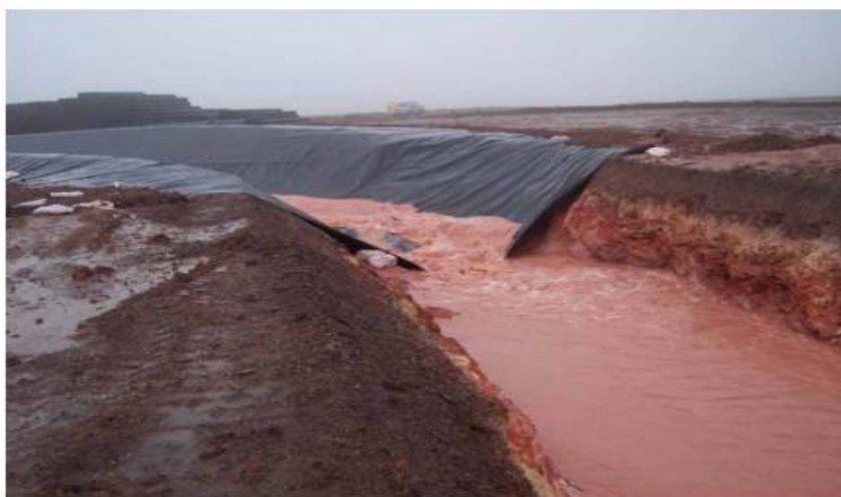
Рис. 1.12. Сброс атмосферных осадков со штабелей КВ в тропических местностях
